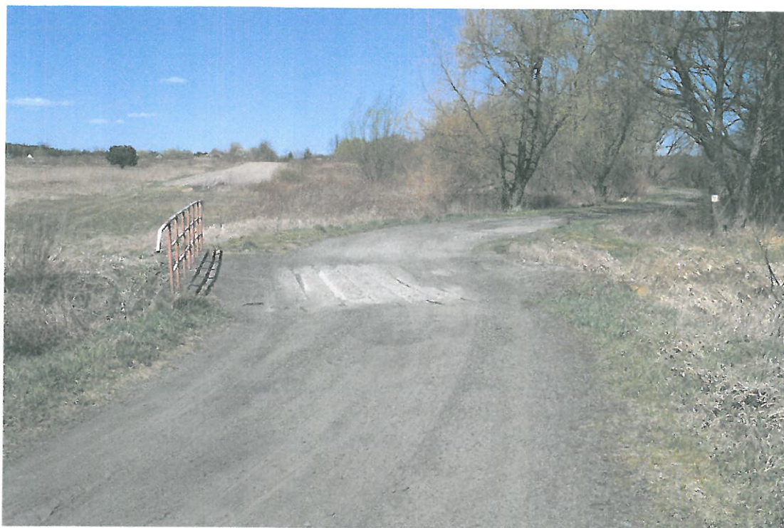
Fot. 1. Widok mostu od strony dojazdu prawobrzeżnego.
