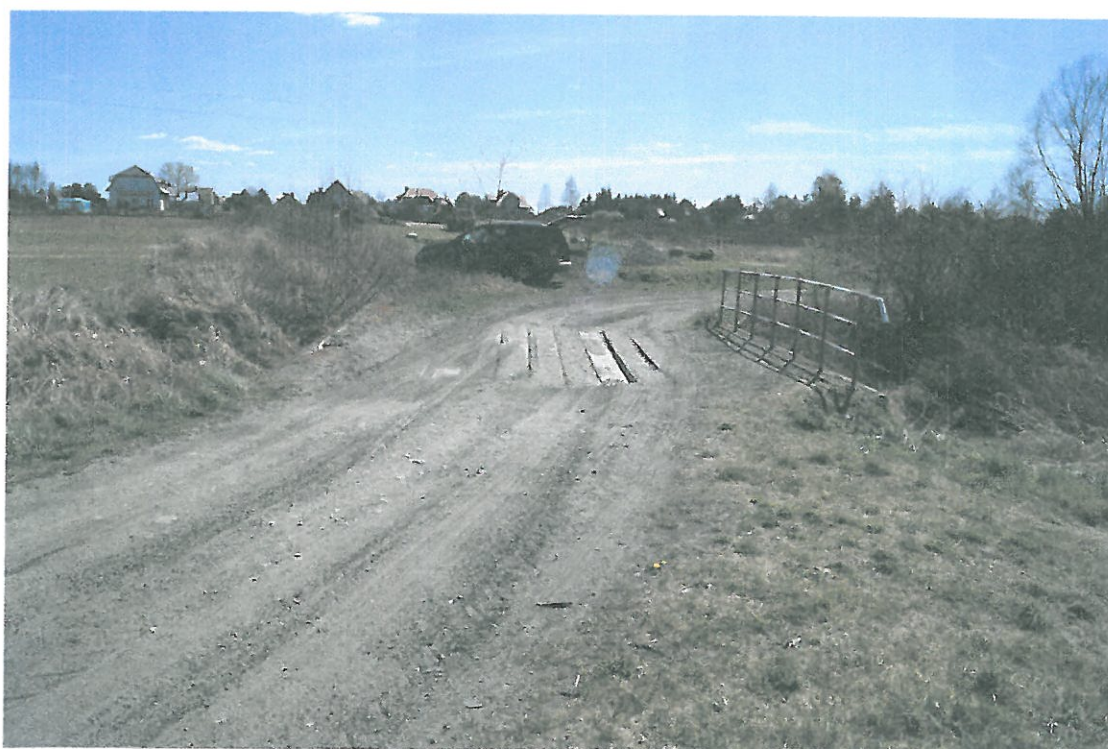
Fot. 2. Widok mostu od strony dojazdu lewobrzeżnego.
