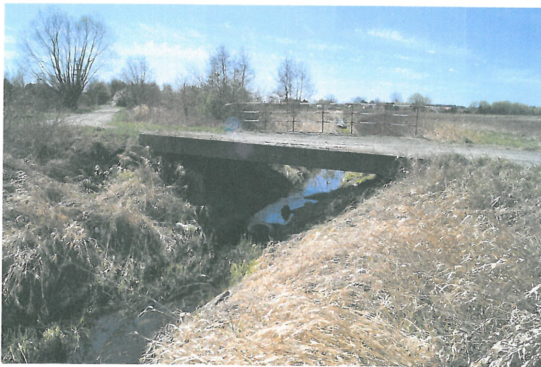
Fot. 4. Widok mostu z brzegu lewego od strony wody dolnej.
