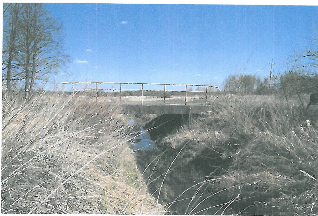
Fot. 3. Widok mostu z brzegu lewego od strony wody górnej.
