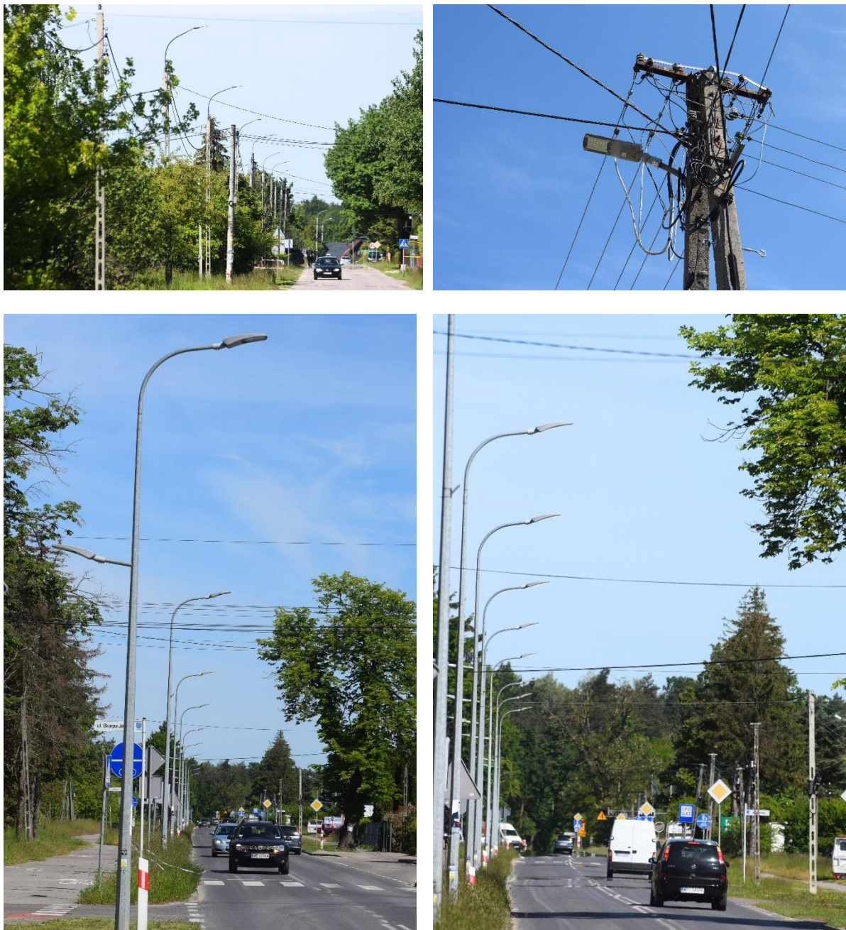
Ryc. 16 Modernizacja oświetlenia zewnętrznego: wymiana słupów oraz montaż opraw energooszczędnych LED. Autor: Joanna Grela
