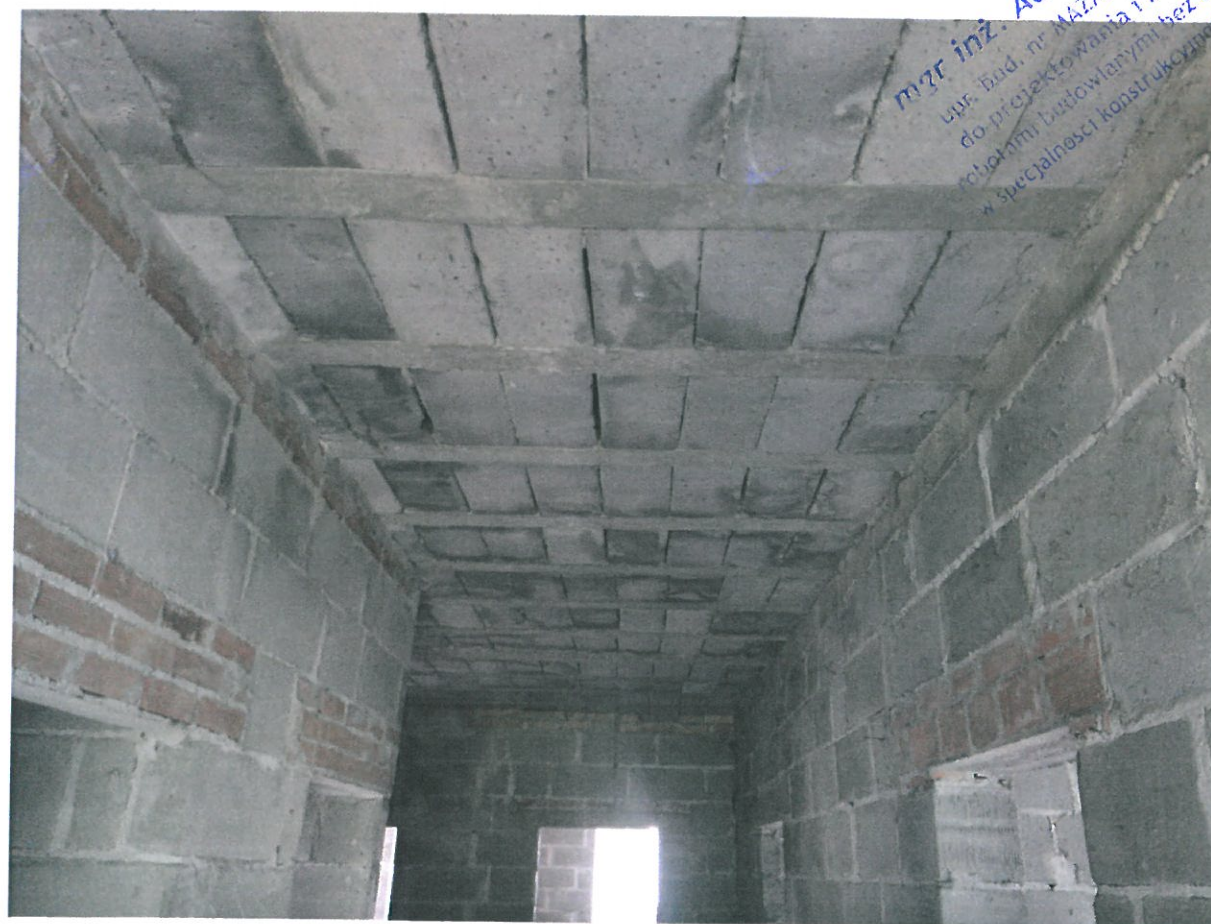
Fot. 8 Strop Teriva nad parterem - korytarz.
