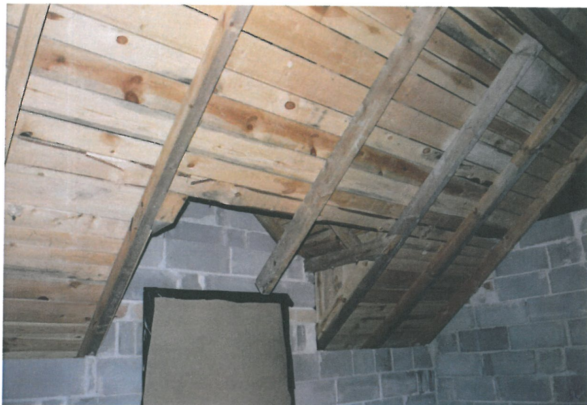
Fot. 19 Inna lukarna, w której brak wymiany. Natomiast dla odmiany (fot. 17), krokw środkowa lukarny jest wyłożona długą.
