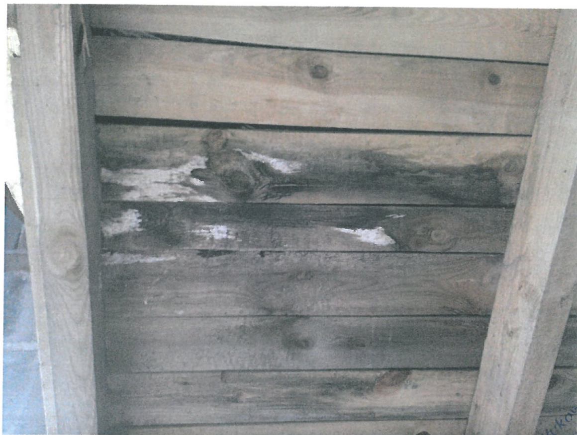
Fot. 15 Na niektórych deskach ślady białej pleśni domowej.
