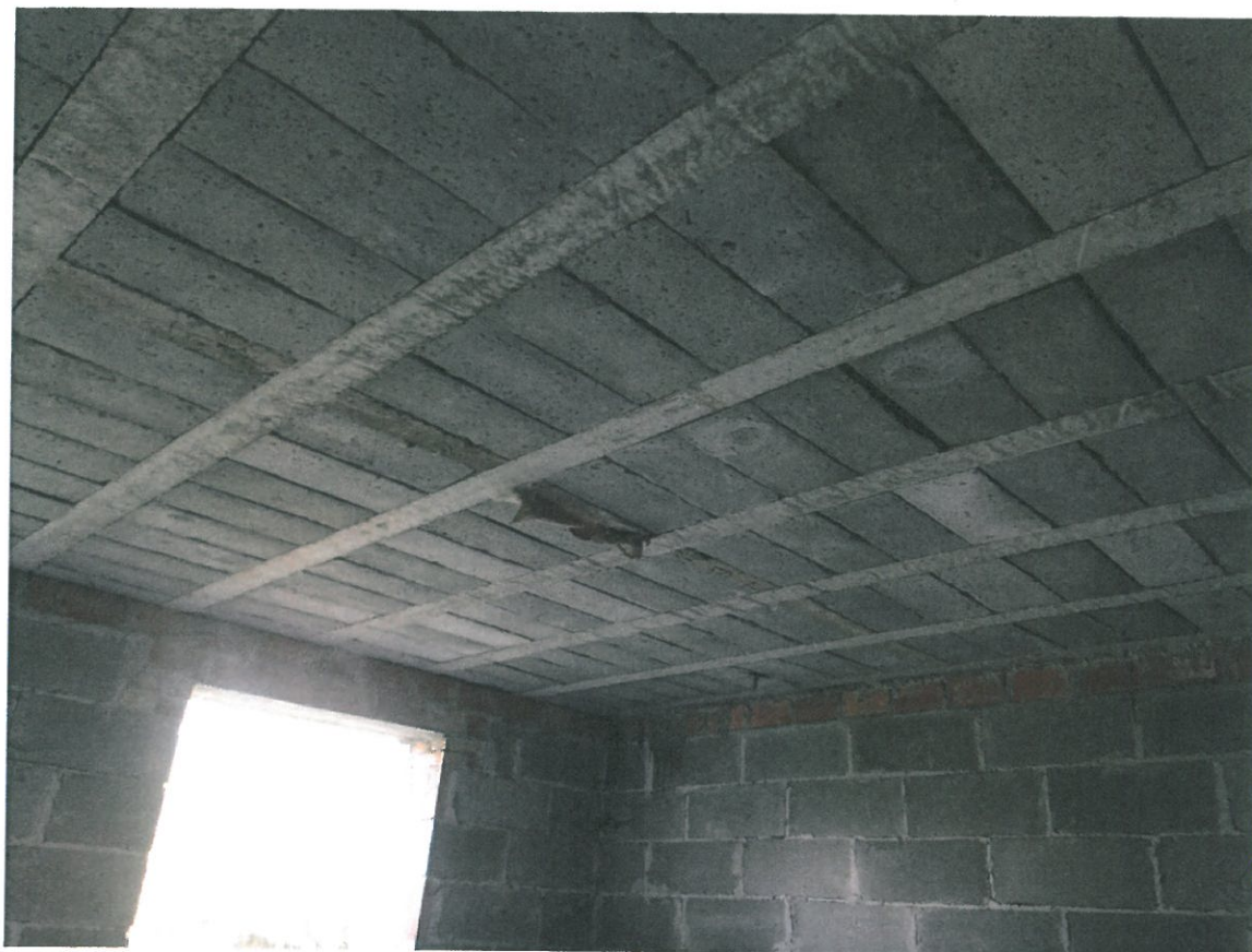
Fot. 9 Strop nad parterem w pomieszczeniu w narożniku północno-wschodnim.
